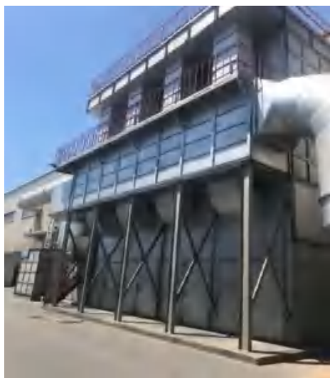
急冷装置+活性炭喷射+旋风除尘+布
