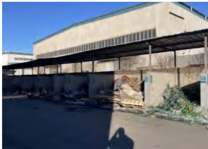
一般工业固废暂存区
